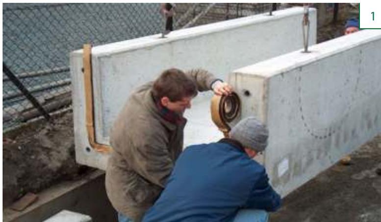
2. Colocar RubberElast con la capa de protección de papel hacia arriba en el centro de la superficie a rejuntrar y comprimirlo con fuerza en toda su longitud para evitar un desplazamiento de la obturación en la colocación del siguiente componente.
