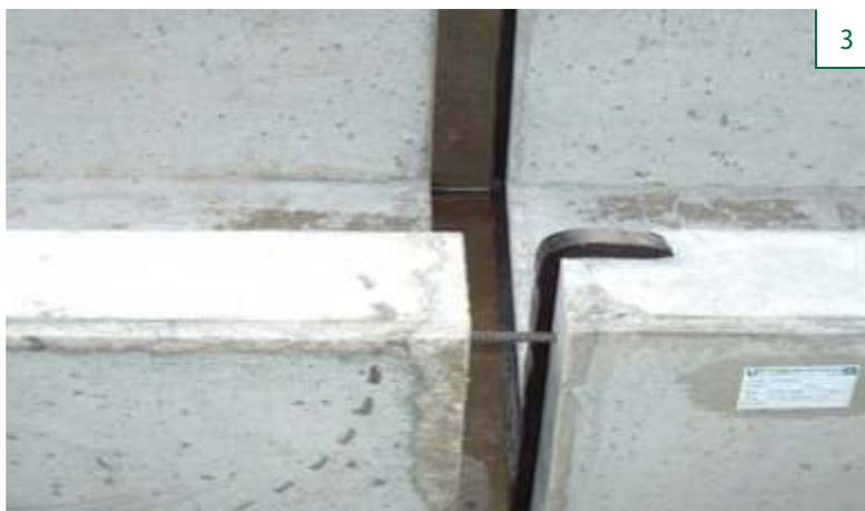
4. Justo antes de la colocación del siguiente componente deben quitarse las tiras de protección y debe comprobarse sin la tira de obturación RubberElast® está montada de forma estable y sin desplazamiento en el lugar deseado.
