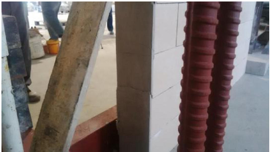
Momento. del inicio de la rotura de la fábrica de bloques en el paño vertical en cuyo extremo superior se estaba aplicando la carga.
